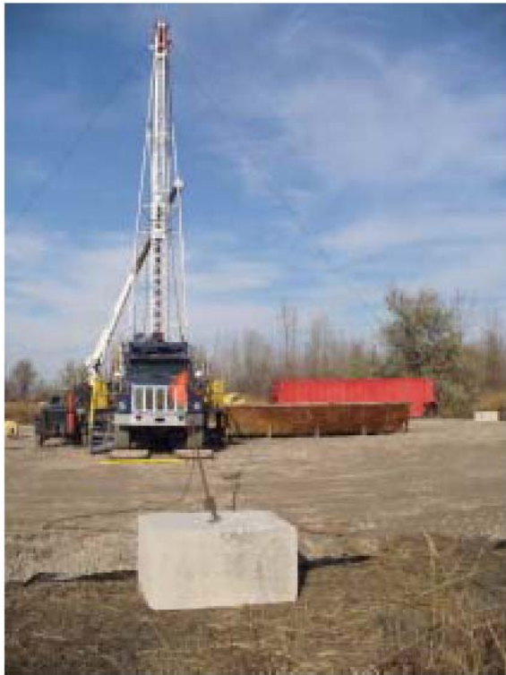
Cable Tool Rig on OPG Property, Nov 2006
