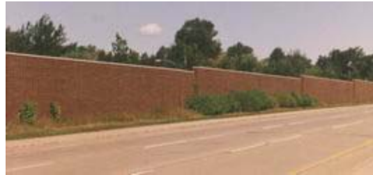
Muro antiruido de Michigan típico
