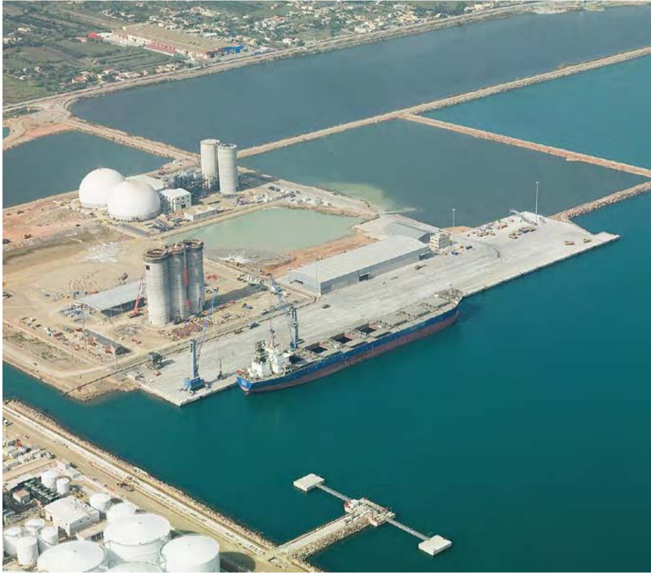
Castellón Bulk Terminal ■
