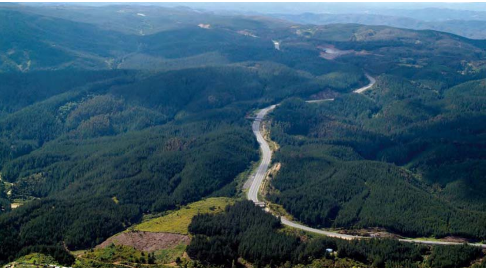
■ SCADI, Itata Highway
